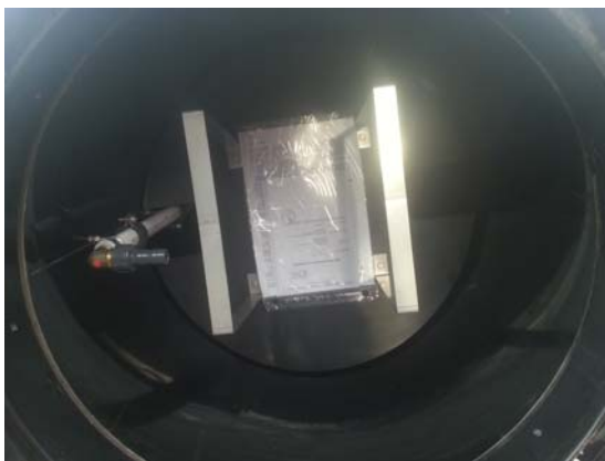
Vista interna de la arqueta del Digestor.
