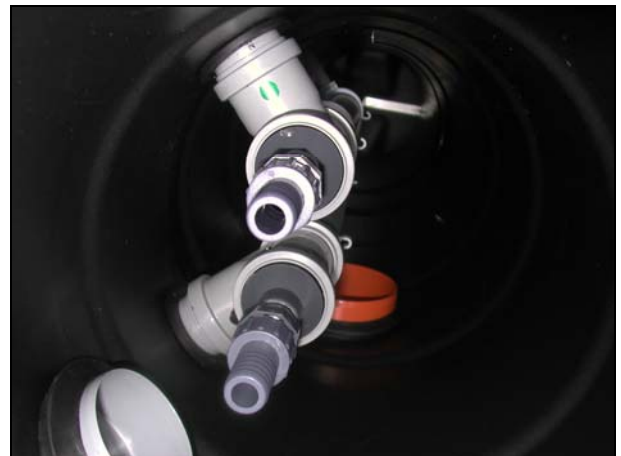
Vista interna de la arqueta del Clarificador
