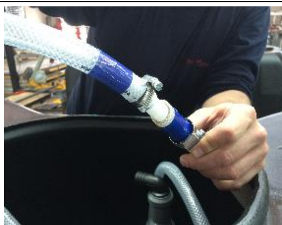
Conexión de la manguera que irá al cuadro eléctrico con la manguera del Air-Lift
