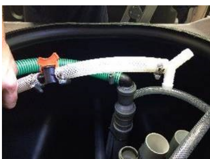
Imagen 10 Unión de las mangueras de los difusores en el depósito digestor, grifo de regulación y salida de mangueras
