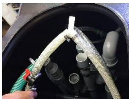
Imagen 10 Unión de las mangueras de los difusores en el depósito digestor, grifo de regulación y salida de mangueras
