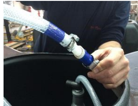
Imagen 7 Conexión de la manguera que irá al cuadro eléctrico con la manguera del Air-Lift
