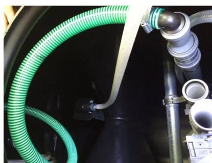
Imagen 9 Instalación de los difusores en los depósitos decantadores y en el Digestor 8-10 MicroStar
