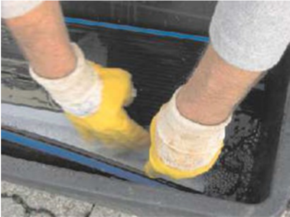
Imagen 8 Limpieza manual de membranas
